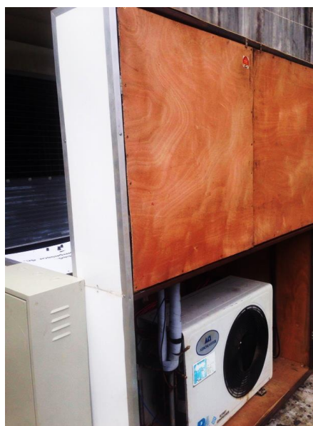
รูปที่ 13 ส่วนด้านหลังของชุดระบบปรับอากาศคอมเพรสเซอร์ กระแสตรงที่ใช้พลังงานแสงอาทิตย์
