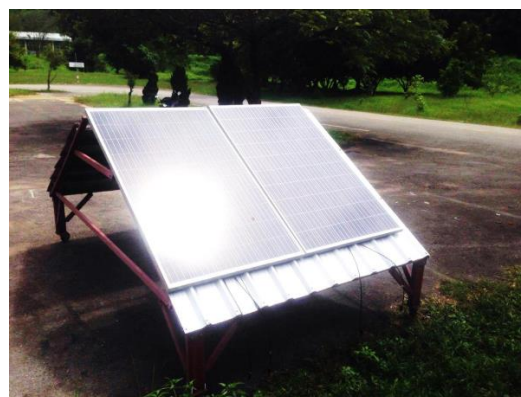
รูปที่ 14 การติดตั้งแผงเซลล์แสงอาทิตย์
